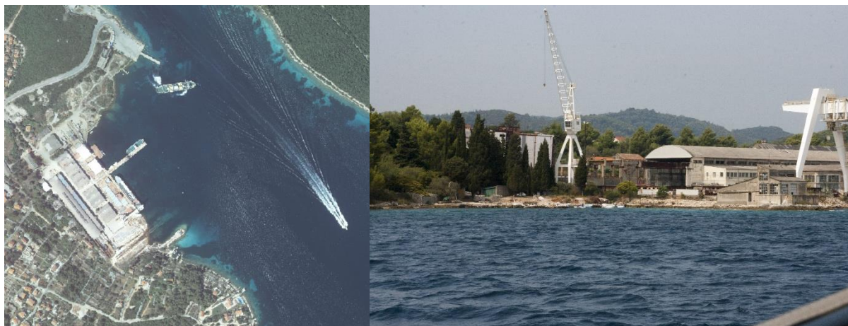
Slika 169. Ortofoto snimka brodogradilišta i trajektnog pristaništa Dominče
