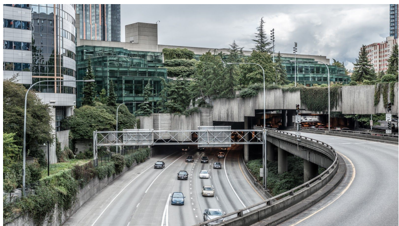
Slika 110. Fotografija specifične lokacije Freeway Parka Lawrence Halprina (Seattle)
