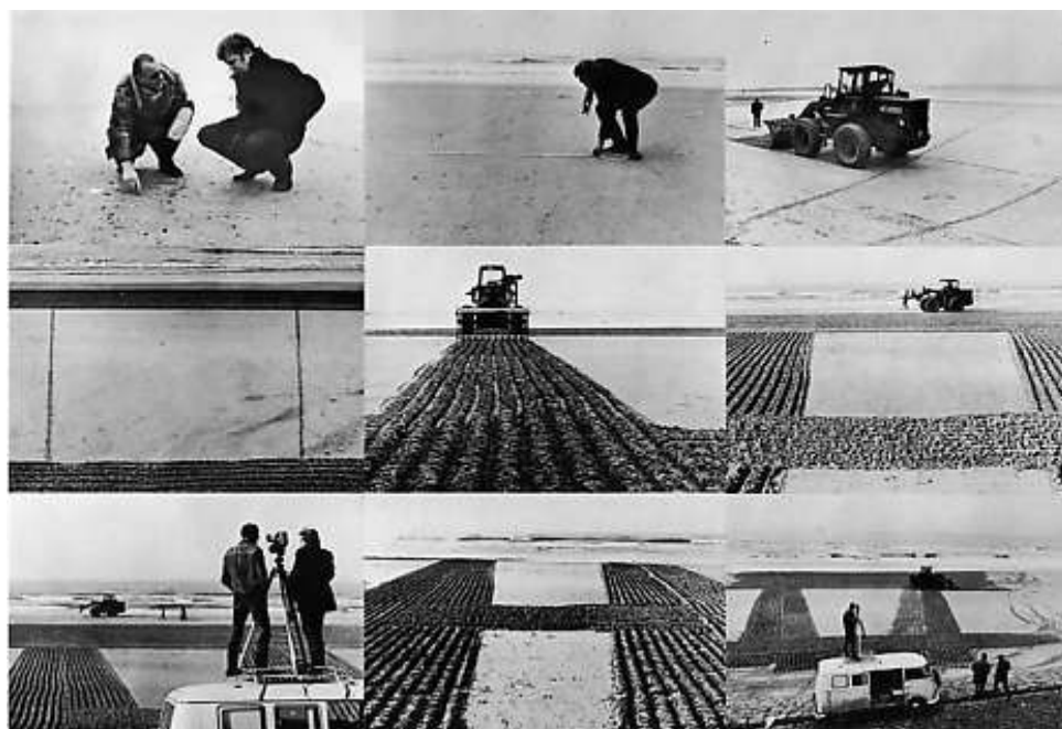
Slika 90. Kolaž fotografija izvedbe Dibbetsova projekta (1969.)
