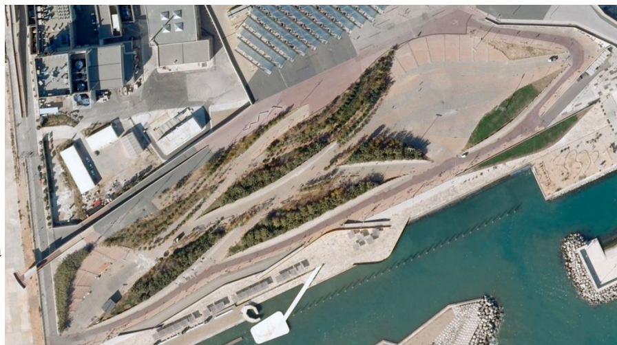
Slika 115. Zračna fotografija Southeast Coastal Parka u Barceloni, arhitektonskog ureda FOA
