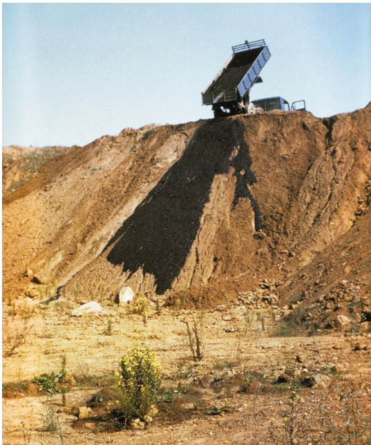
Slika 39. Fotografija izvedbe rada Asphalt
