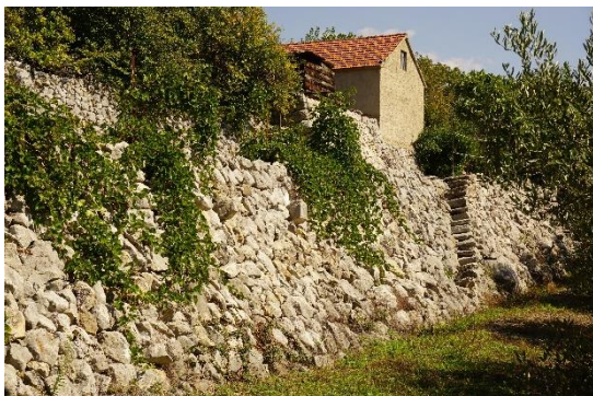
Sl.7.16.3. Visoka „škalka“ s interpoliranim stepenicama
