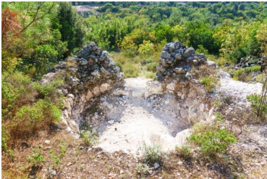
Sl.7.2.5. Klačina zapaljena 2000. godine, s ugašenim vapnom u najnižem dijelu
