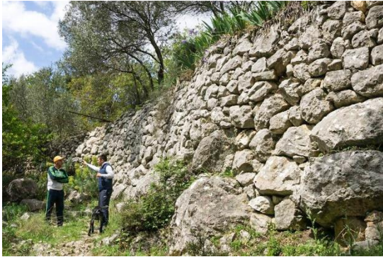
Sl.7.18.5. Visoki podzid Pijeve ulice, 4,1 m
