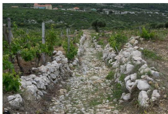
Sl.7.12.8. Kamenom opločan i suhozidom omeđen put u vinogradu
