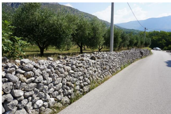
Sl.7.19.5. Podzid uz cestu
