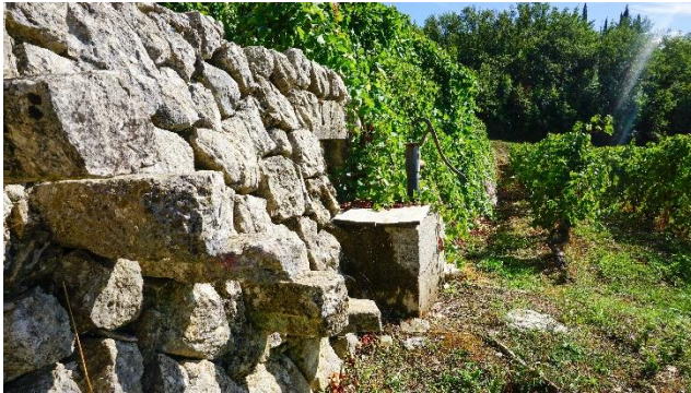
Sl.7.24.5. Interpolacija stepenica u podzid, te gustjerne s ručnom pumpom
