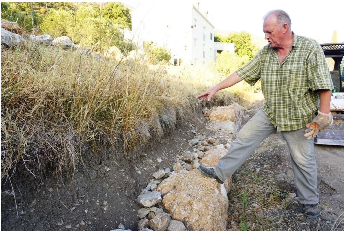
Sl. 8.2.1. Vlaho Vlahutin objašnjava tehniku gradnje podzida
