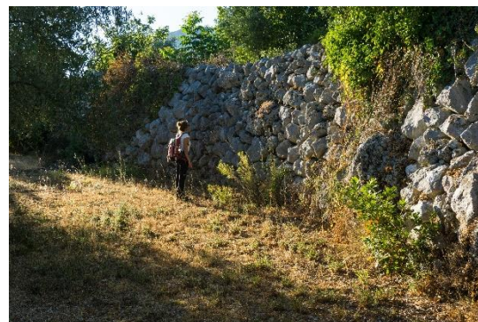
Sl.7.25.4. Visoki podzid terase
