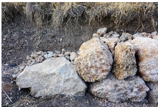
Sl.7.14.4. Početak podzidavanja – kamen vapnanac i breča
