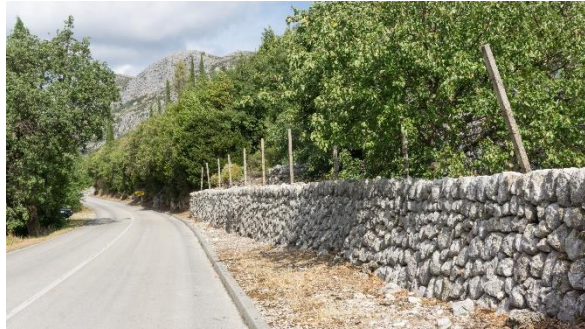
Sl.7.17.2. Podzid uz glavnu prometnicu
