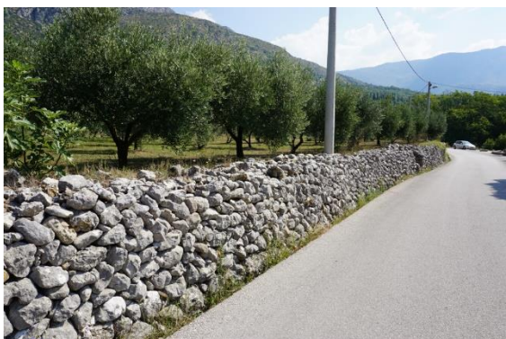
Sl.7.19.5. Podzid uz cestu
