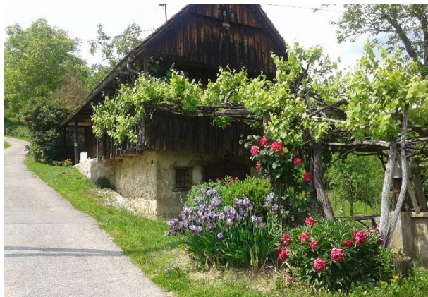
Slika 12.: Kuća u Donjem Oštrcu (foto: Relić, 2016.)
