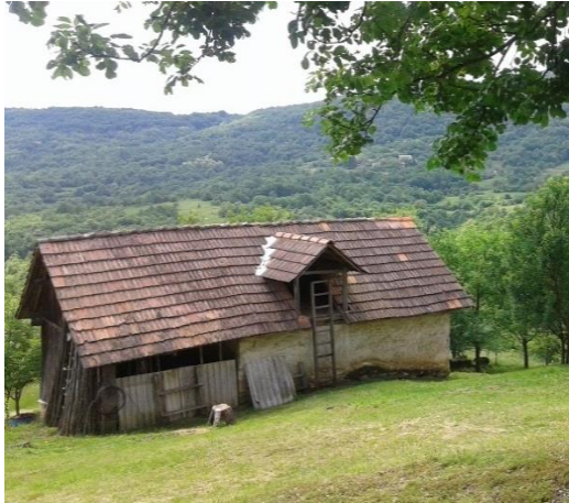
Slika 10. Oštrc, gospodarska zgrada (foto: Relić, 2016.)
