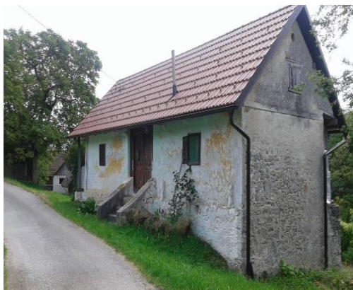
Slika 6.: Kamena kuća (foto: Relić, 2016.)
