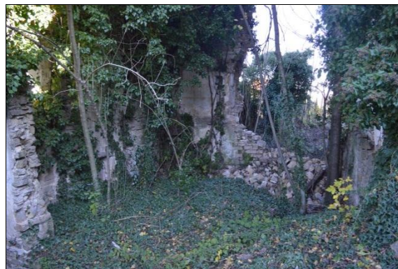
Sl. 23: Ruševna zgrada u zapuštenom području
