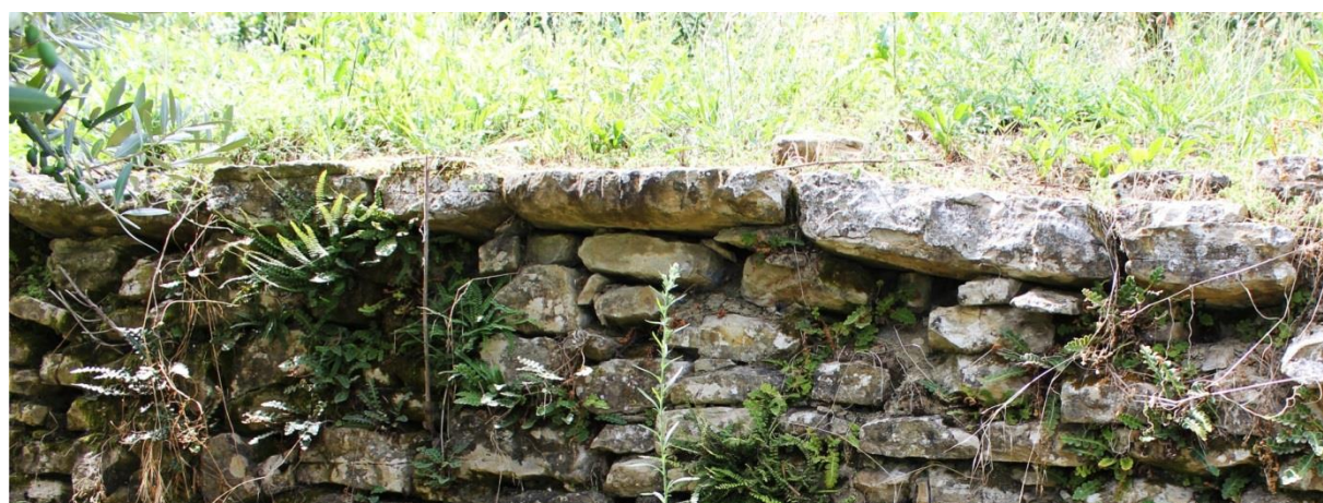
Slika 3.58. Završetak zida s većim, položenim komadima kamena
