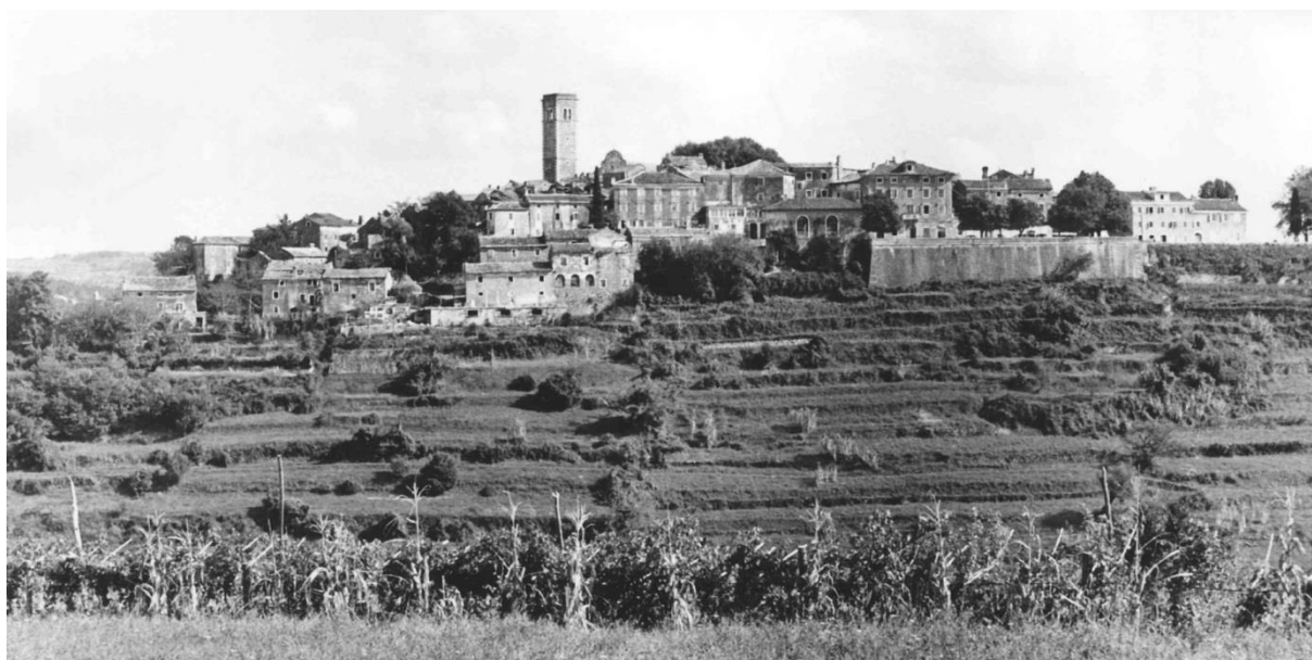
Slika 3.37. Pogled na Oprtlj sa zapada (Ž. Malinarić, 1974.)
