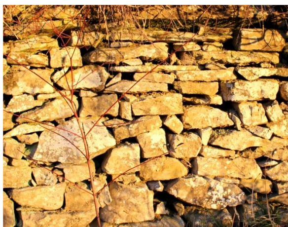
Slika 3.53. Zid većinom zidan nepravilnim kamenim blokovima u neurednim redovima (zapad obuhvata)
