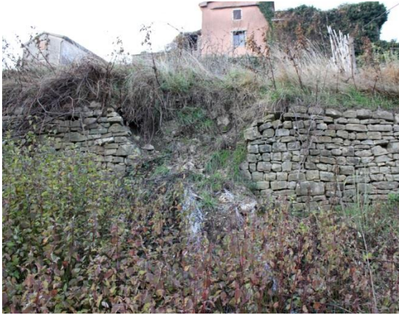
Slika 4.6. Urušeni suhozid ispod naselja i zidina
