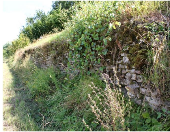
Slika 4.7. Neodržavani suhozid uz obrađenu terasu
