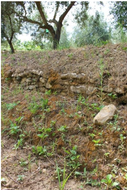
Slika 4.8. Dugogodišnji nanosi sedimenta prekrili su gotovo dvije trećine visine suhozida
