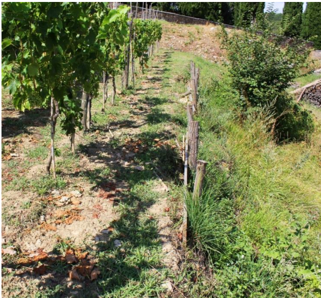
Slika 4.3. Mjesto erozije u sjevernom dijelu obuhvata
