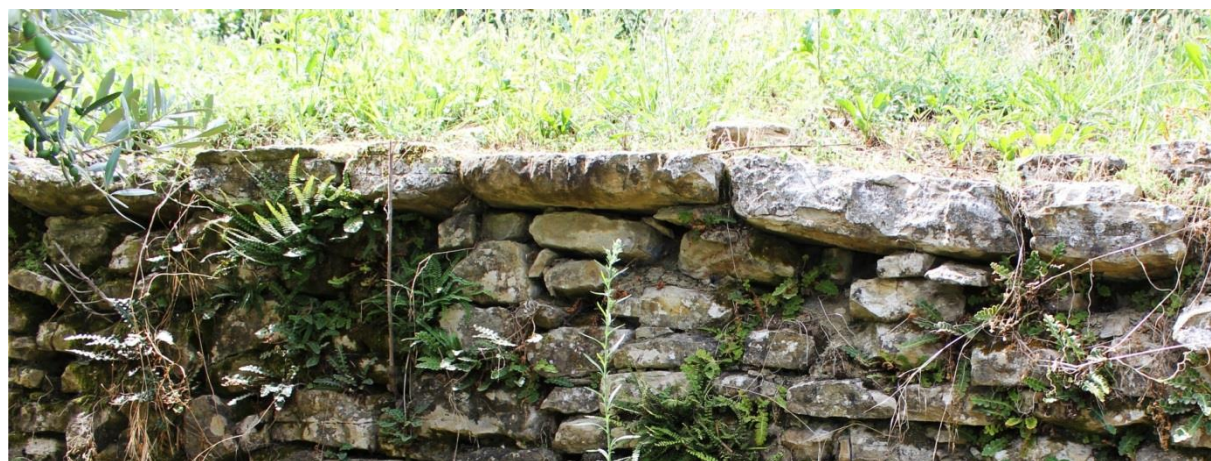
Slika 3.58. Završetak zida s većim, položenim komadima kamena
