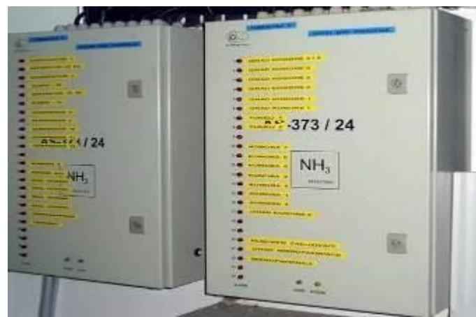
Slika 60. Uređaj za detekciju štetnih emisijskih plinova
