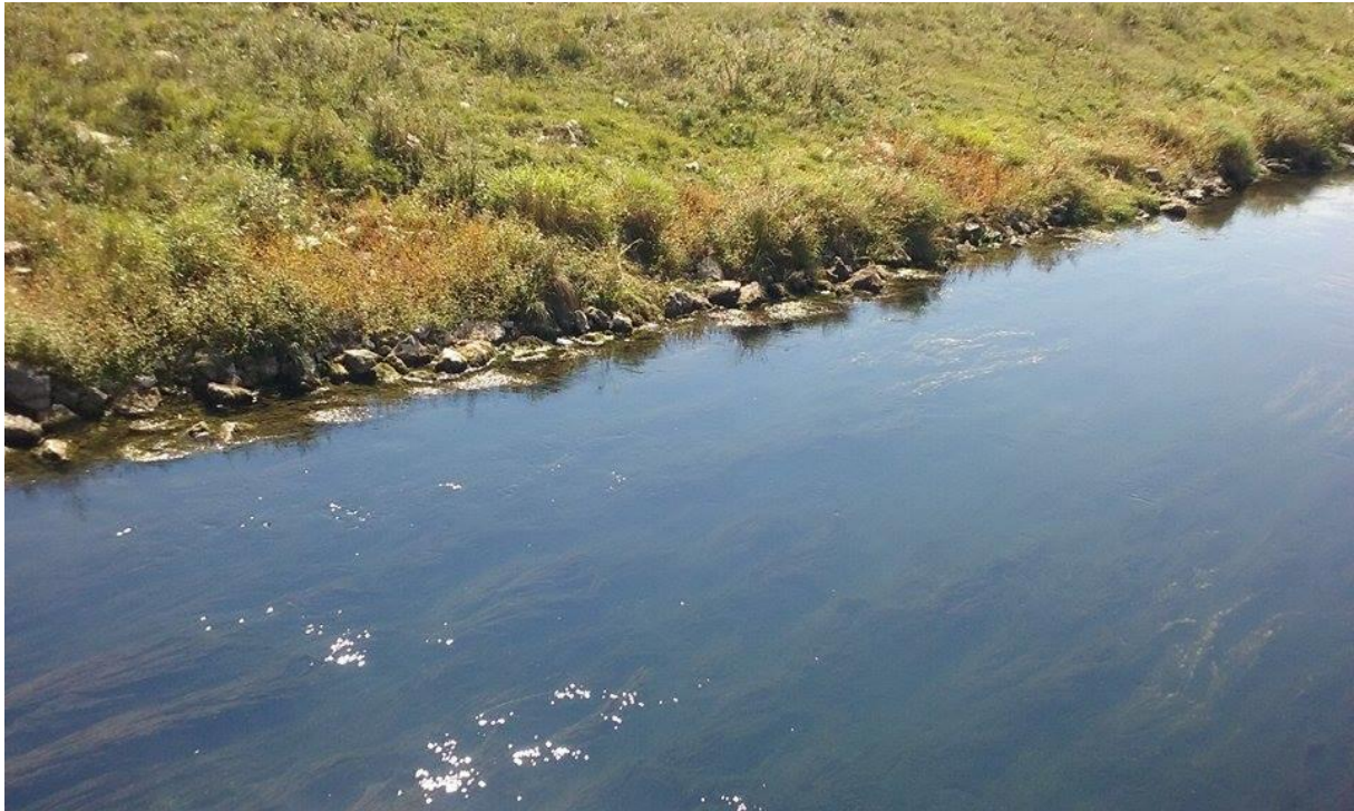
Slika 8.: Slabo održavani dno i pokos kanala I reda
