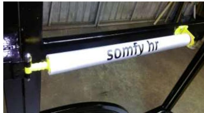
Slika 61. Prikaz montaže cijevnog elektromotora na vrata traktora
