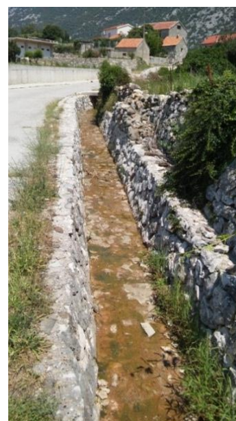
Slika 55.: Linearan vodotok ograđen cementiranim suhozidom, Ostrvica
