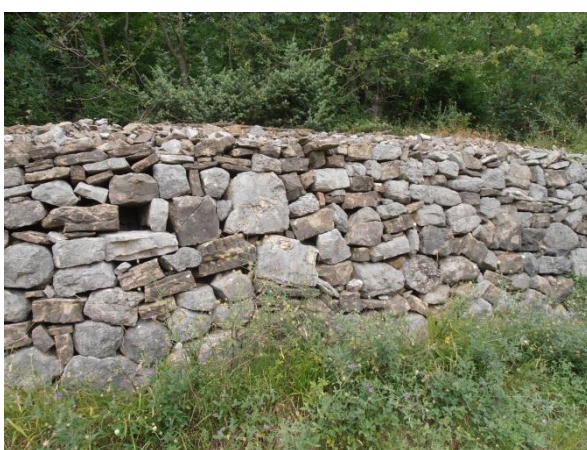
Slika 78.: Način slaganja suhozida, Čisla
