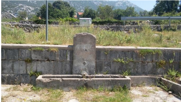
Slika 58.: Izgrađeni presušeni izvor, Ostrvica
