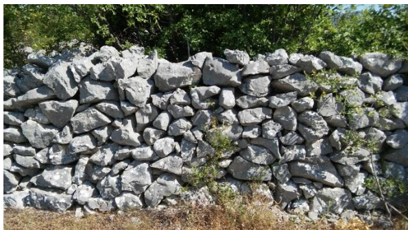
Slika 79.: Način slaganja suhozida, Kostanje
