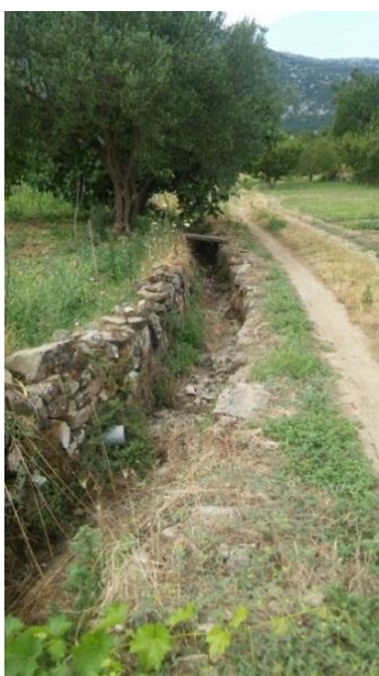
Slika 53.: Suhozidom regulirani vodotok, Kostanje
