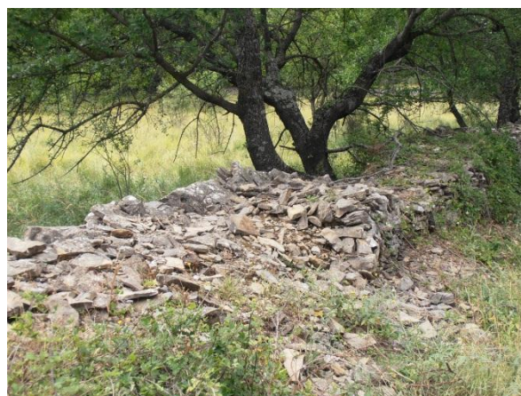
Slika 86.: Dvostruki suhozid, Čisla
