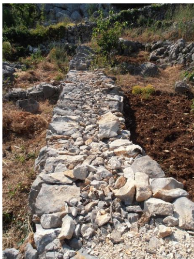
Slika 83.: Gornja obrada suhozida, Podgrađe
