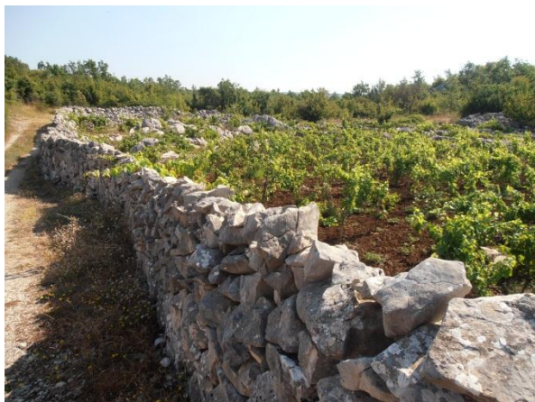
Slika 85.: Jednostruki suhozid, Podgrađe
