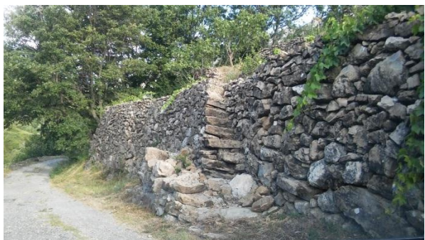
Slika 71.: Potporni suhozid uz prometnicu, Smolonje
