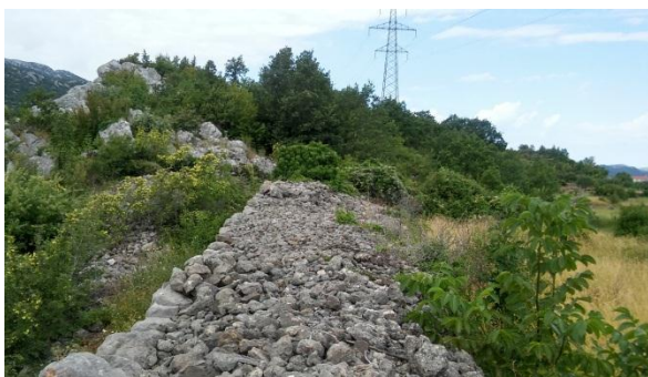
Slika 82.: Gornja obrada suhozida, Kostanje
