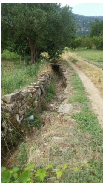
Slika 53.: Suhozidom regulirani vodotok, Kostanje
