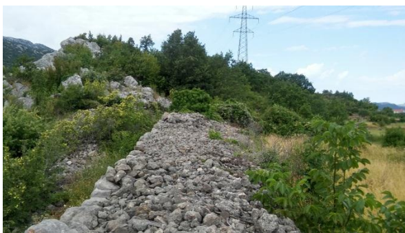
Slika 82.: Gornja obrada suhozida, Kostanje
