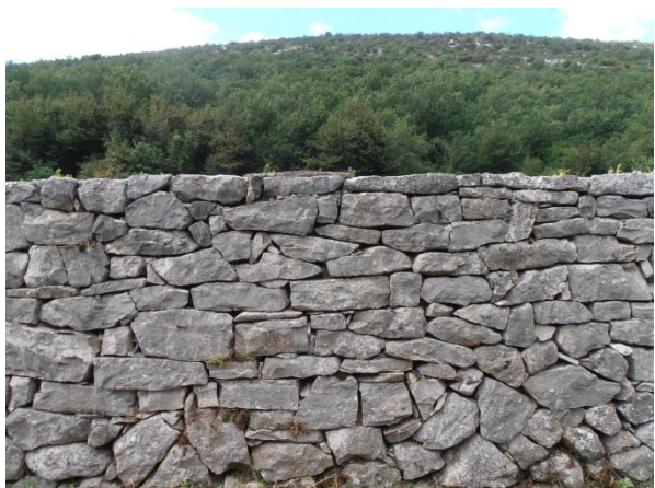
Slika 77.: Način slaganja suhozida, Gata
