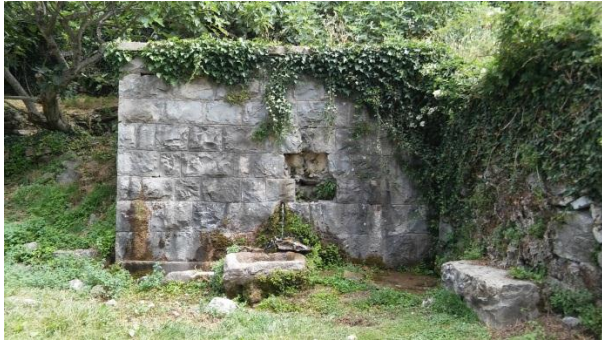
Slika 56.: Izgrađeni izvor, Kostanje
