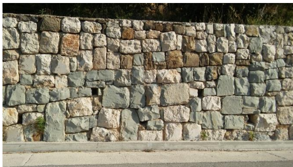
Slika 80.: Način slaganja suhozida, Podgrađe
