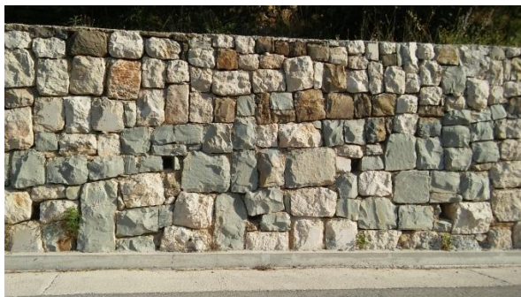
Slika 80.: Način slaganja suhozida, Podgrađe
