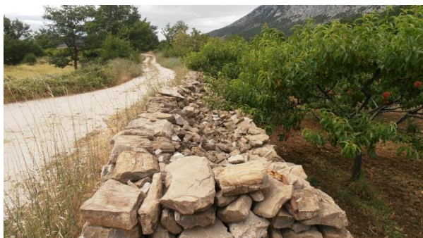
Slika 81.: Gornja obrada suhozida, Čisla
