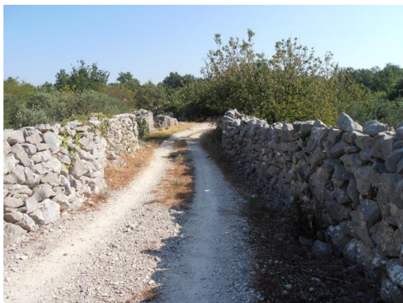
Slika 43.: Omeđeni put, Podgrađe
