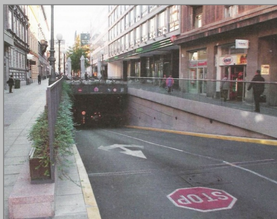
Slika 29: ulaz u podzemnu garažu na Cvjetnom trgu, izvor: Zlatar 2013.
