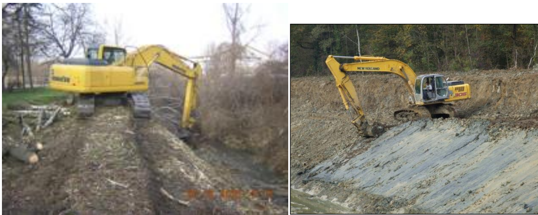
Slika 19. Prikaz obnove melioracijskih kanala II i III reda
