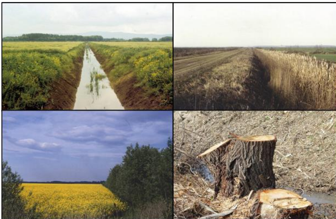
Slika 13. Prikaz velike obraslosti otvorenih melioracijskih kanala III i IV reda kao posljedica lošeg održavanja
