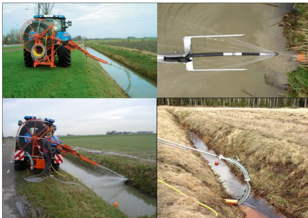
Slika 22. Prikaz ispiranja drenažnih cijevi specijalnim strojem
