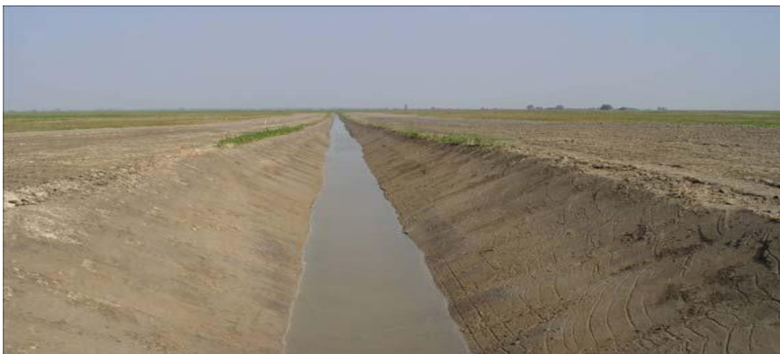
Slika 8. Prikaz melioracijskog kanala III/ IV reda.
