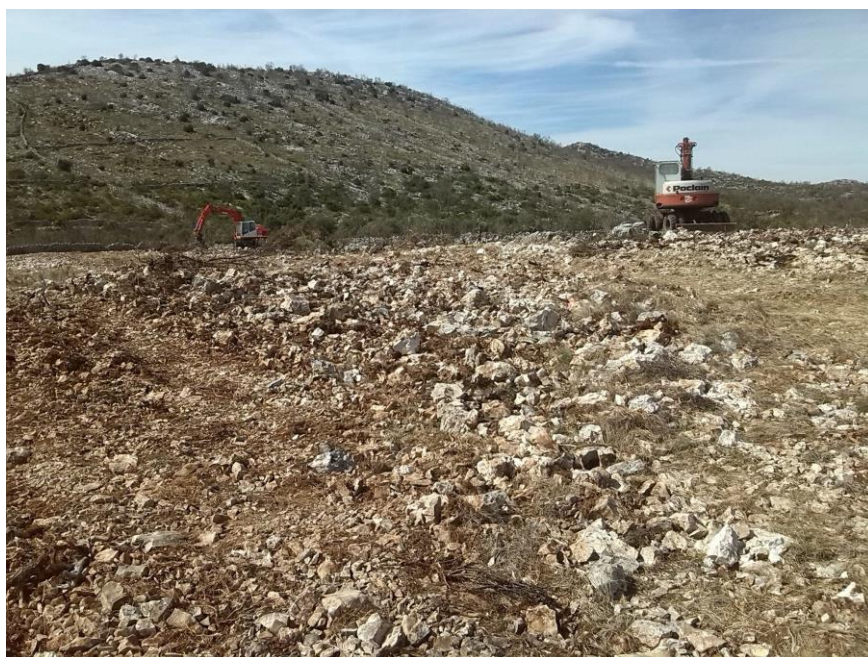
Slika 3. Uklanjanje kamenih gromada i podzemne biomase (Izvor : Rajner Perica)
