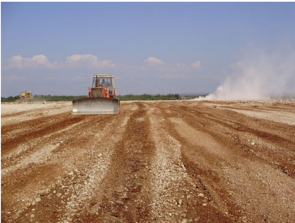
Slika 6. Niveliranje terena ( Izvor: Rajner Perica)
