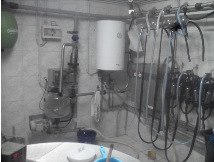
Slika 21. Početak pranje sustava (Foto: Švub)
