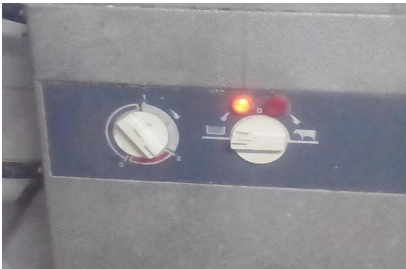
Slika 22. 1. faza, pranje hladnom vodom (Foto: Švub)
