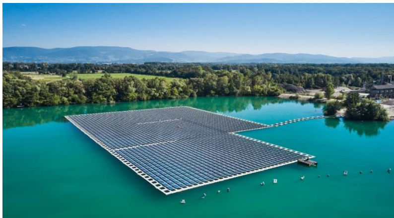
Slika 6. Prikaz plutajućih solarnih panela na jezeru
