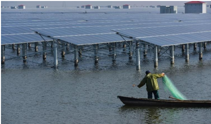
Slika 3. Prikaz kombinirane djelatnosti akvakulture i proizvodnje električne energije
