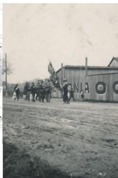
Slika 125. Pogled na tvornicu Badel Sesvete sa Zagrebačke ceste 1935. godine, Izvor: (fotodokumentacija, Muzej Prigorja)
