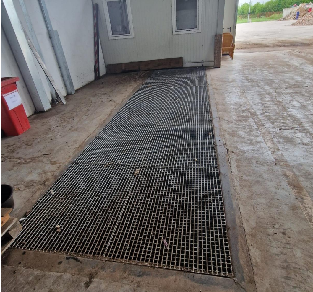
Slika 21. Prikaz prvog bazena za sakupljanje oborinske vode Izvor: E. Nekret-Katić, 2023.
