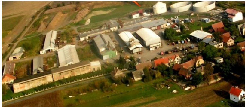
Slika 3. Bioenergetsko postrojenje u Knežicama
