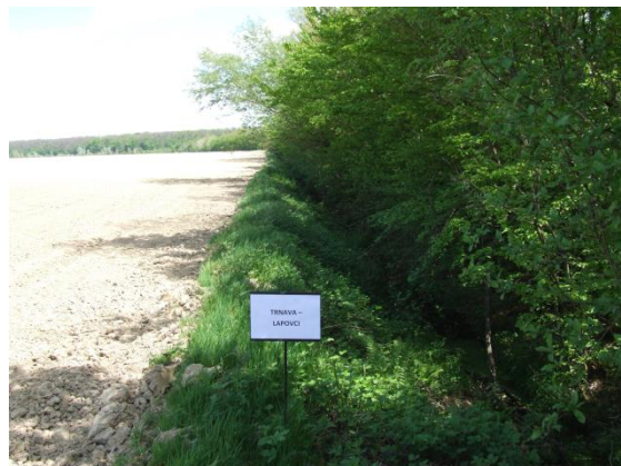
Slika 8. Neodržavan melioracijski kanal Lapovci (Petošić i sur., 2015)
