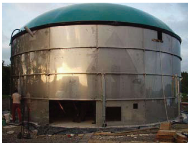
Slika 5. Fermentor u izgradnji
