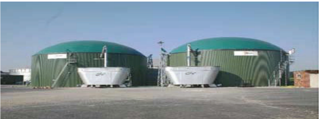
Slika 1. Dozatori i fermentori bioplinskog postrojenja
