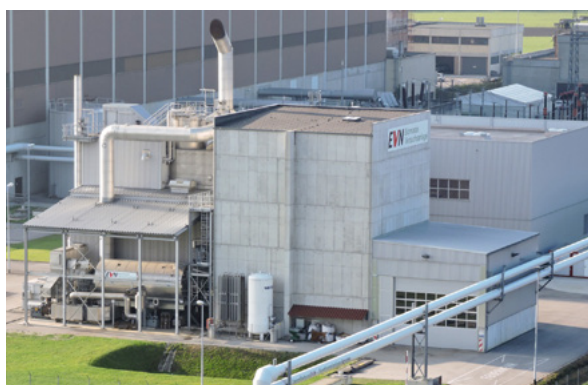
Slika 54. Postrojenje za termičku obradu mulja Durnrohr Austrija ( www.sludge2energy.de )
