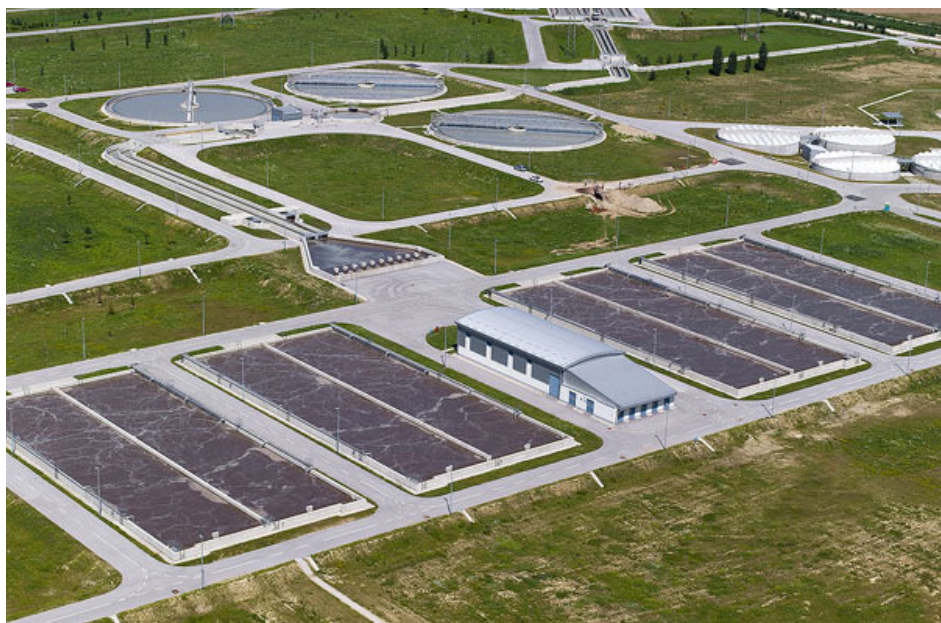
Slika 5. Centralni pročistač otpadnih voda Grada Zagreba ( www.zov-zagreb.hr )
