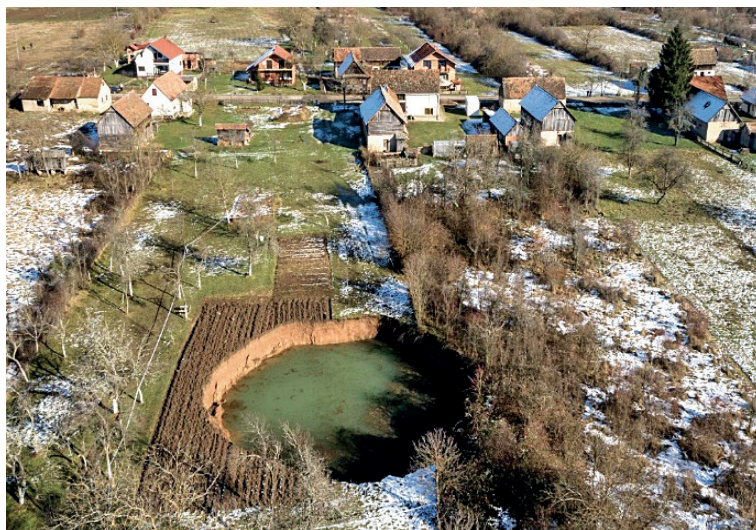
Slika 4. Urušena vrtača Picture 4 Sinkhole
