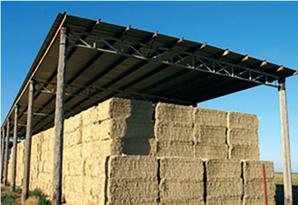
Slika 14. Pokrovna konstrukcija za skladištenje biomase (Izvor: http://bretbergsconstruction.com/services/ )
