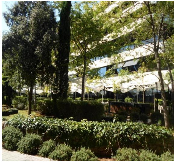
Slika 4.30. Pogled sa šetnice na jugozapadnu stranu hotela
