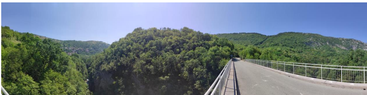
Slika 7-48 Fotodokumentacija s mosta Pašac
