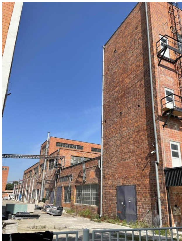
Slika 6. – Degradirane industrijske građevine
