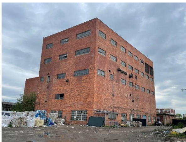
Slika 36.– Degradirana industrijska građevina (S-Z)
