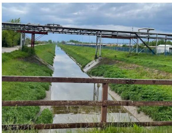
Slika 38.– Glavni odvodni kanal (J)
