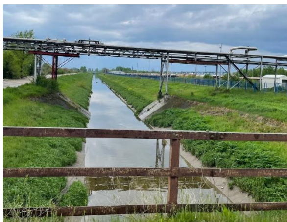
Slika 38.– Glavni odvodni kanal (J)
