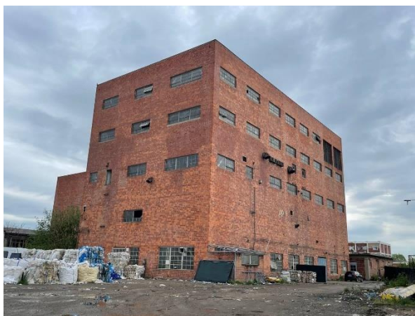
Slika 36.– Degradirana industrijska građevina (S-Z)
