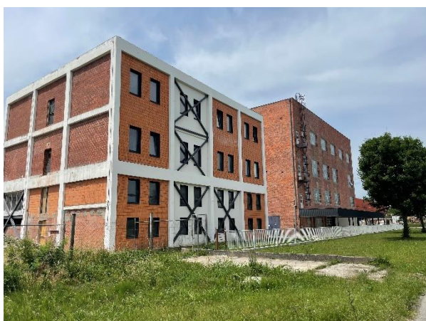
Slika 35.– Degradirana industrijska građevina (S-Z)
