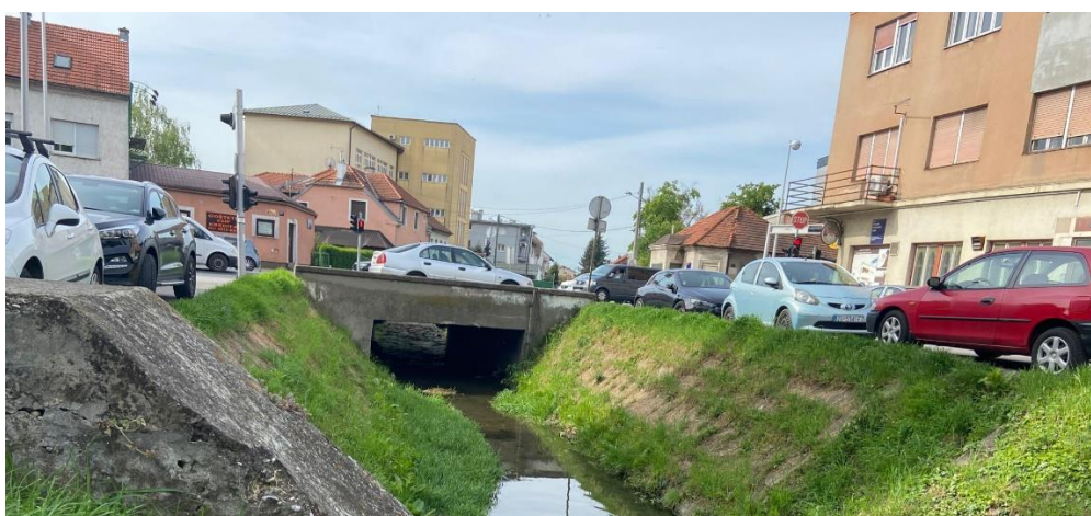
(slika 3.4.3.3 prolaz potoka ispod Ilice kroz kanal, profil kanala zemljanog korita i stranicama koje nadsvodnjem prelaze u betonski tip kanala Ivan Stošić, 2023.)
