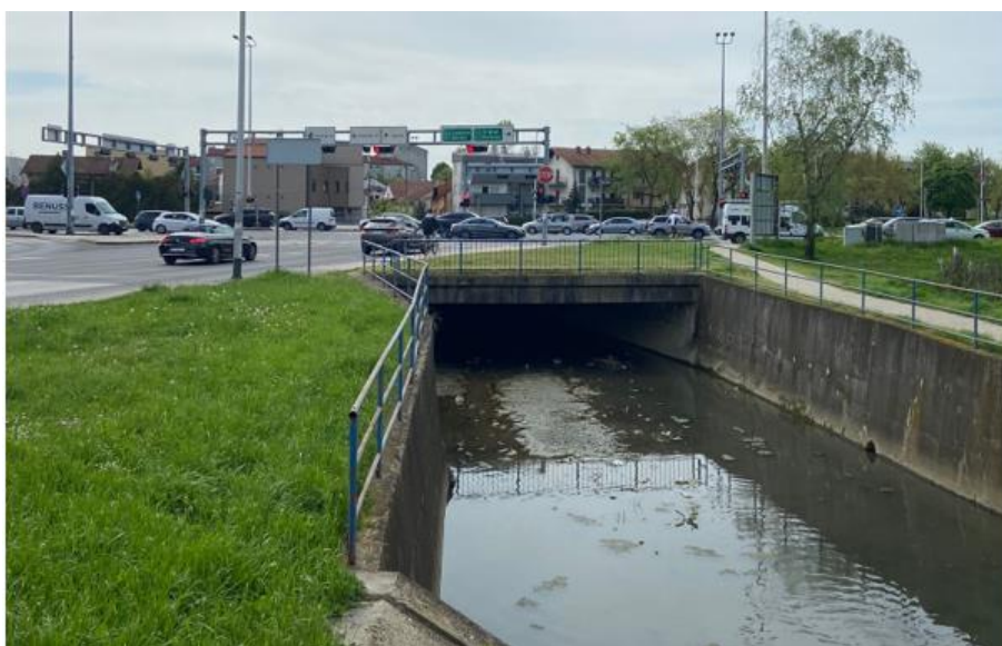
(slika 3.4.3.12 prolaz potoka ispod Zagrebačke avenije kroz kanal, Ivan Stošić, 2023.)
