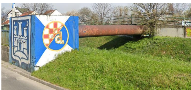
(slika 3.4.5.13 prelazak podzemne infrastrukture preko potoka, Ivan Stošić, 2023.)
