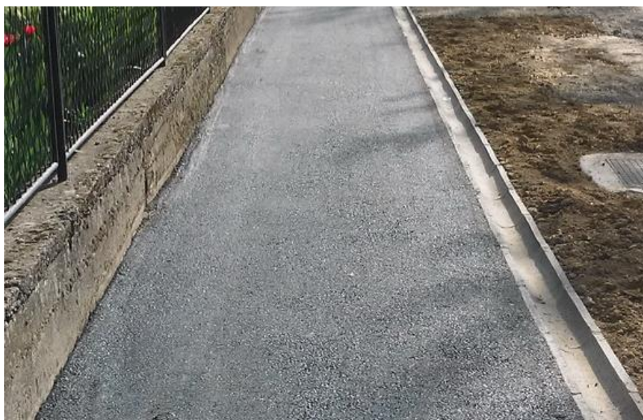
(slika 3.4.5.1. asfaltirana staza, Ivan Stošić, 2023.)
