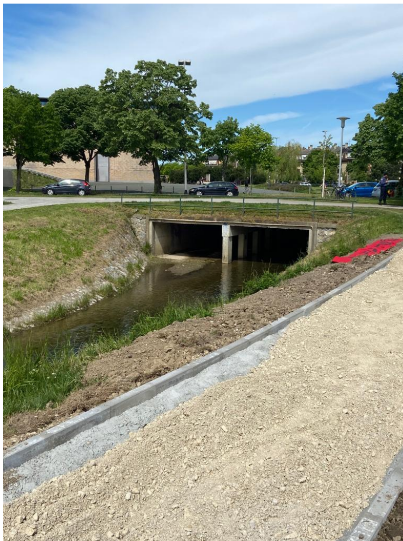
(slika 5.5.8 izgradnja šetnice na lijevoj obali potoka Vrapčak, Ivan Stošić, 2023.)
