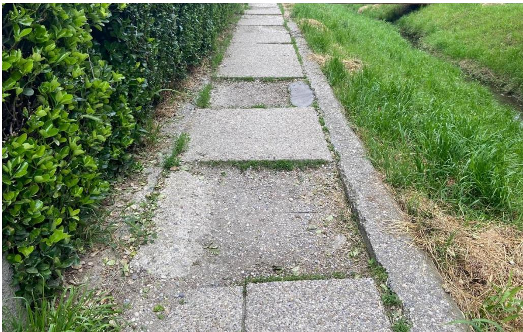
(slika 3.4.5.6 fizička oštećenja betonskih ploča, Ivan Stošić, 2023.)
