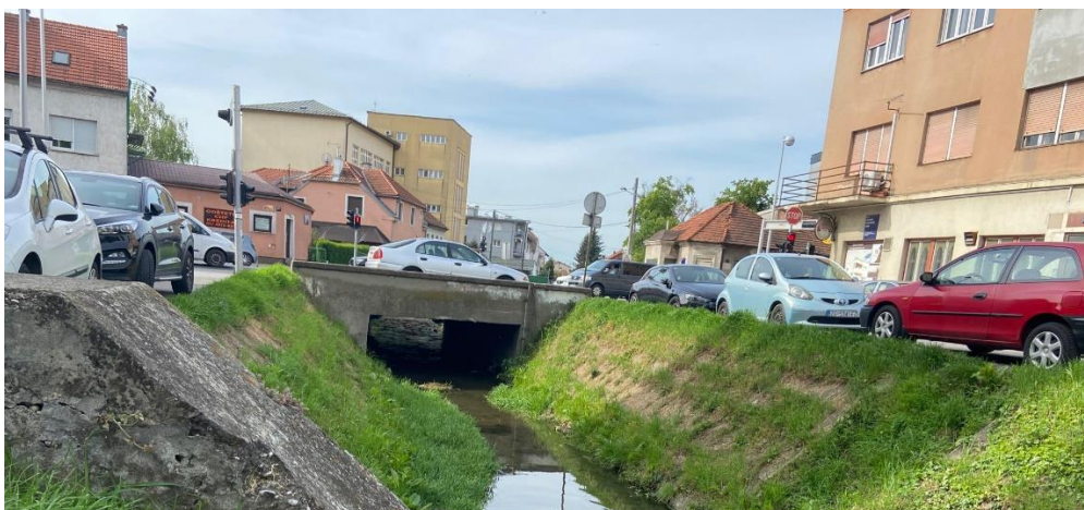
(slika 3.4.3.3 prolaz potoka ispod Ilice kroz kanal, profil kanala zemljanog korita i stranicama koje nadsvodjenjem prelaze u betonski tip kanala Ivan Stošić, 2023.)
