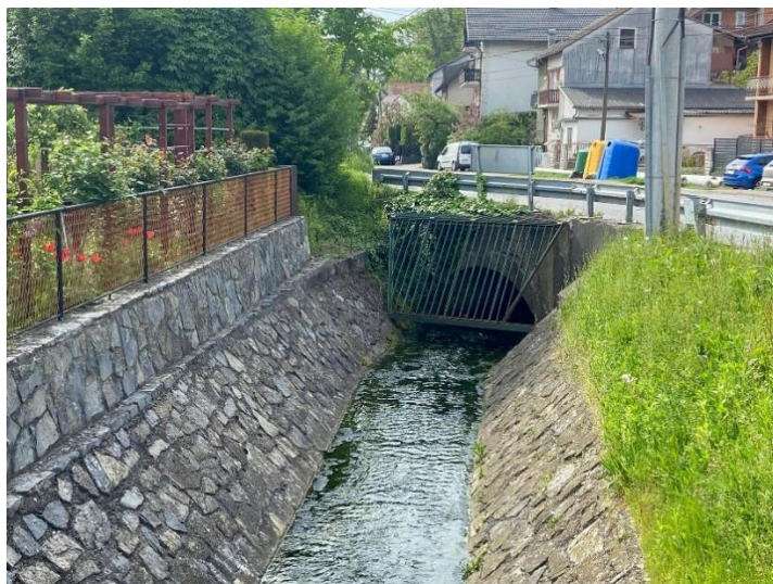
(slika 3.4.1.4 ulaz potoka Kustošak u kanal, Ivan Stošić, 2023.)
