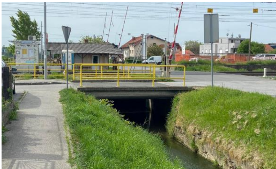
(slika 3.4.3.6 prolaz potoka ispod Ilice kroz kanal, pogled na željeznički prolaz, Ivan Stošić, 2023.)
