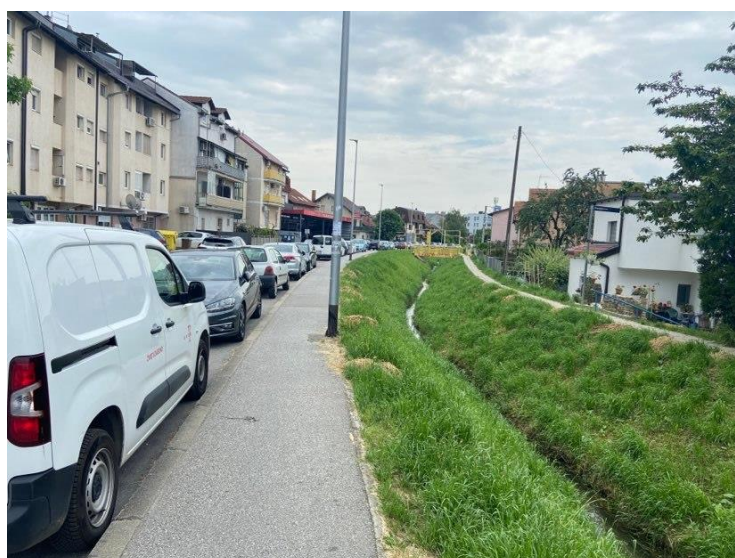
(slika 3.4.5.2. potok kao dio uličnog sklopa, Ivan Stošić, 2023.)
