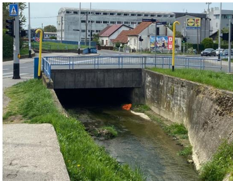
(slika 3.4.3.9 prolaz potoka ispod Zagrebačke i Rudeške ceste kroz kanal, Ivan Stošić, 2023.)
