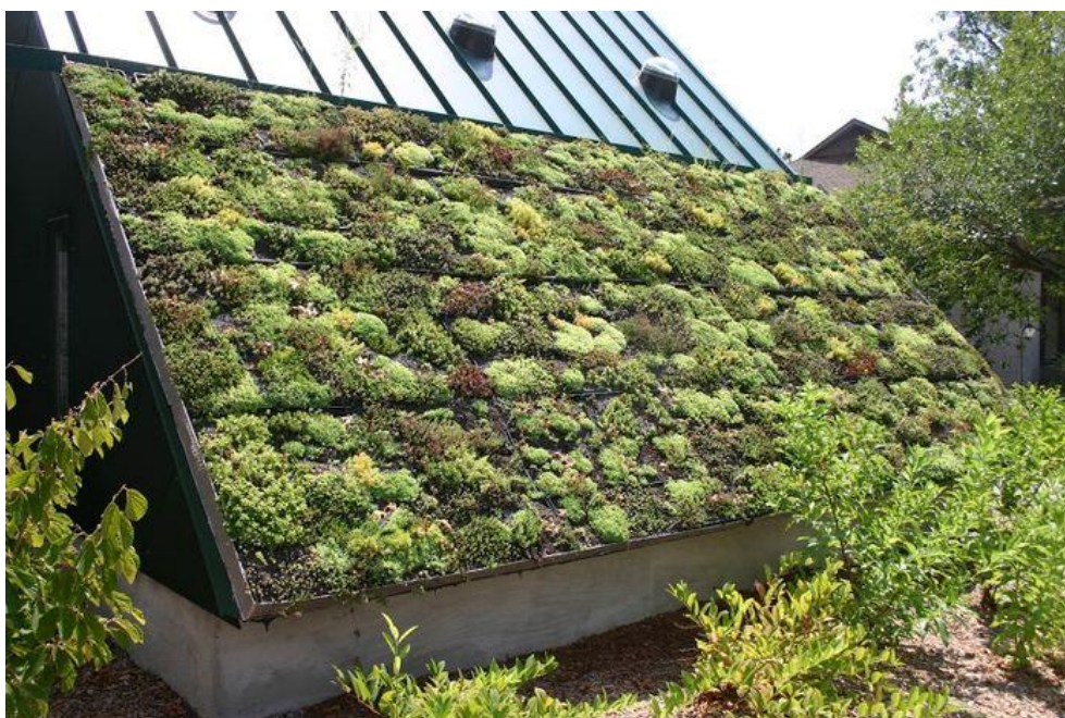
Slika 6. Prikaz primjene ekstenzivno-kosog vrta Izvor: https://odu-green-roof.com/light-extensive-green-roof/
