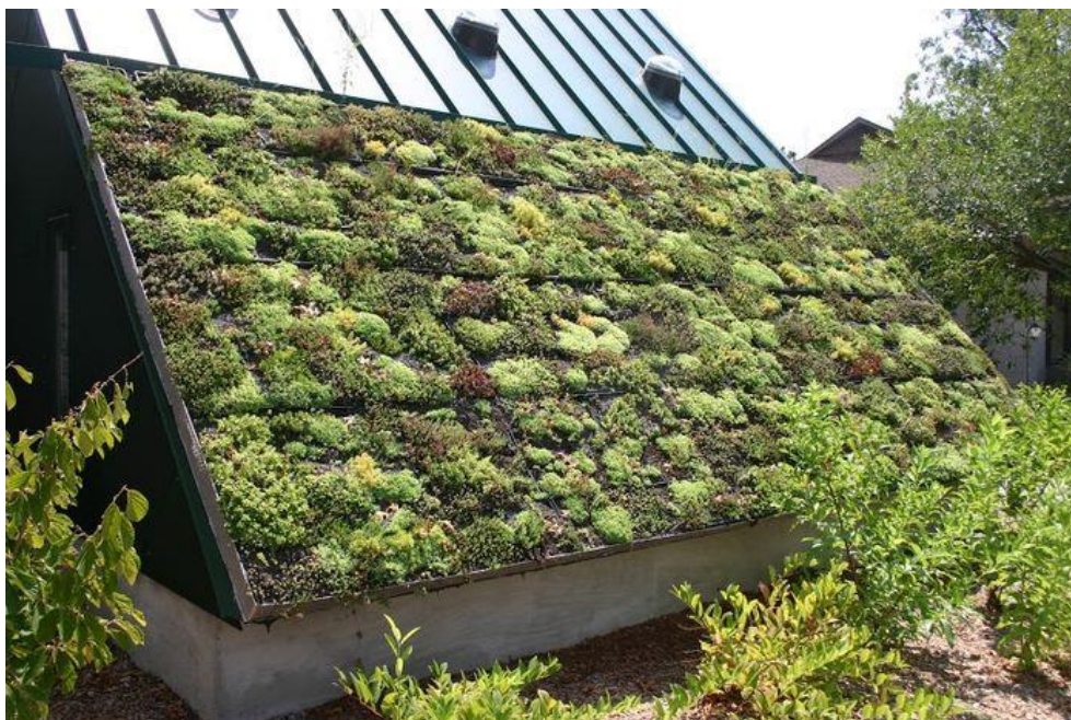
Slika 6. Prikaz primjene ekstenzivno-kosog vrta Izvor: https://odu-green-roof.com/light-extensive-green-roof/
