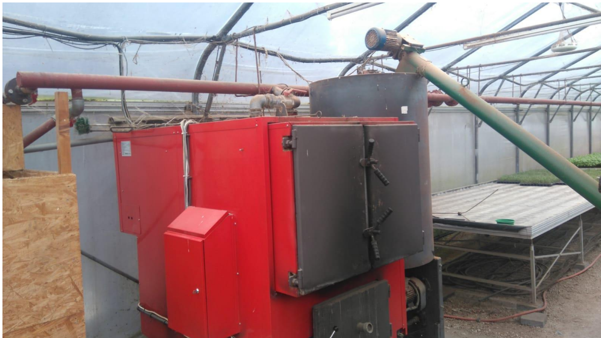
Slika 26: Kotao na kruta goriva sa samosabdijevanjem (Izvor:vlastiti izvor)
