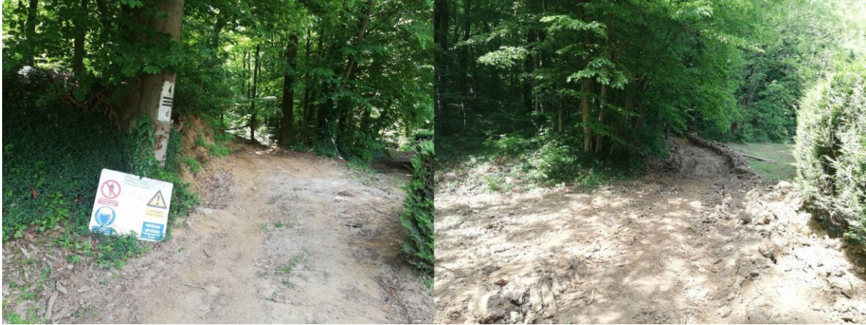
Slika 41. Ostaci gradilišta nakon izvedbe vodozaštitnih elemenata u park-šumi Mirogoj (izvor: izradio autor)
