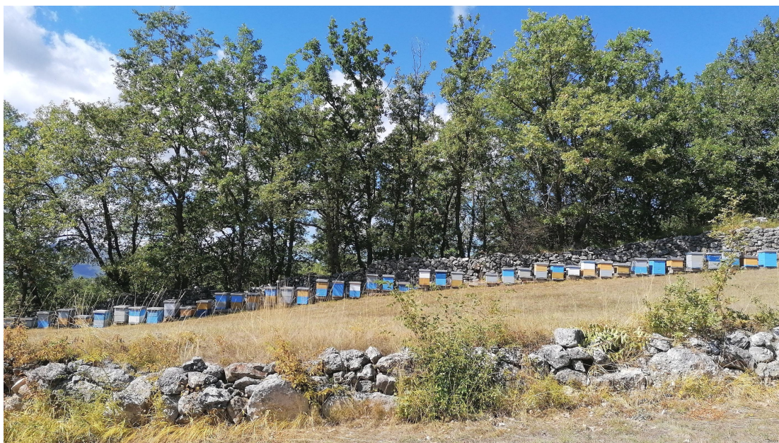
Slika 4.7.3. Djelomično urušena suhozidna gradnja.
