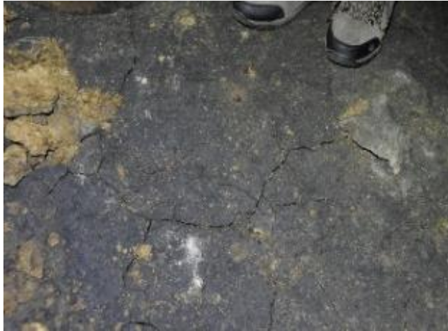
Slika 6.2.2.14.: Pukotine na podu formirane uslijed paljenja vatre i otkinuta stijena
