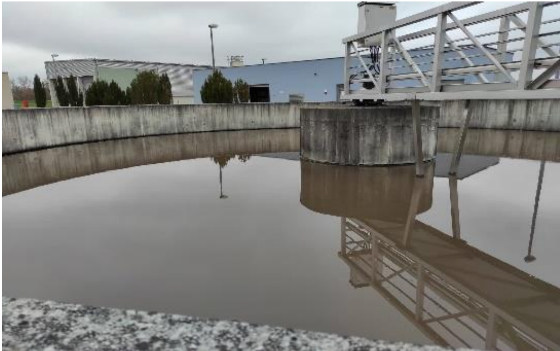
Slika 2.4.1.8. Primarni taložnik
