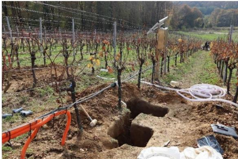
Slika 3.2.1. Iskop jame za postavljanje tlačnih lizimetara
