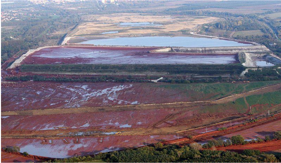
Slika 11. Razmjeri štete nakon pucanja zida lagune (Mađarska, Ajka 2010.godina)
