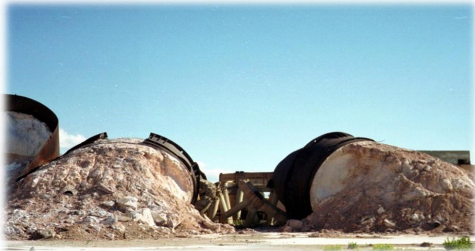
Slika 2. Srušeni silosi na području tvornice Jadral
