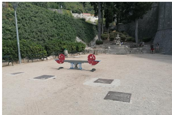
Slika 3.2.5.8. Park Pile – šahtovi kod sprava
