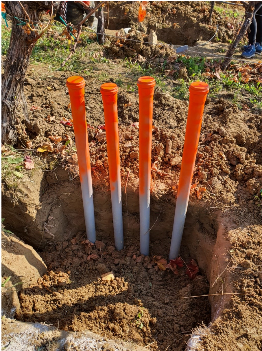
Slika 3.3.4. Zatrpavanje rupe postepenim utiskivanjem tla. (Autentična fotografija 2. studenoga 2020. Autor: Blanka Horvatić)
