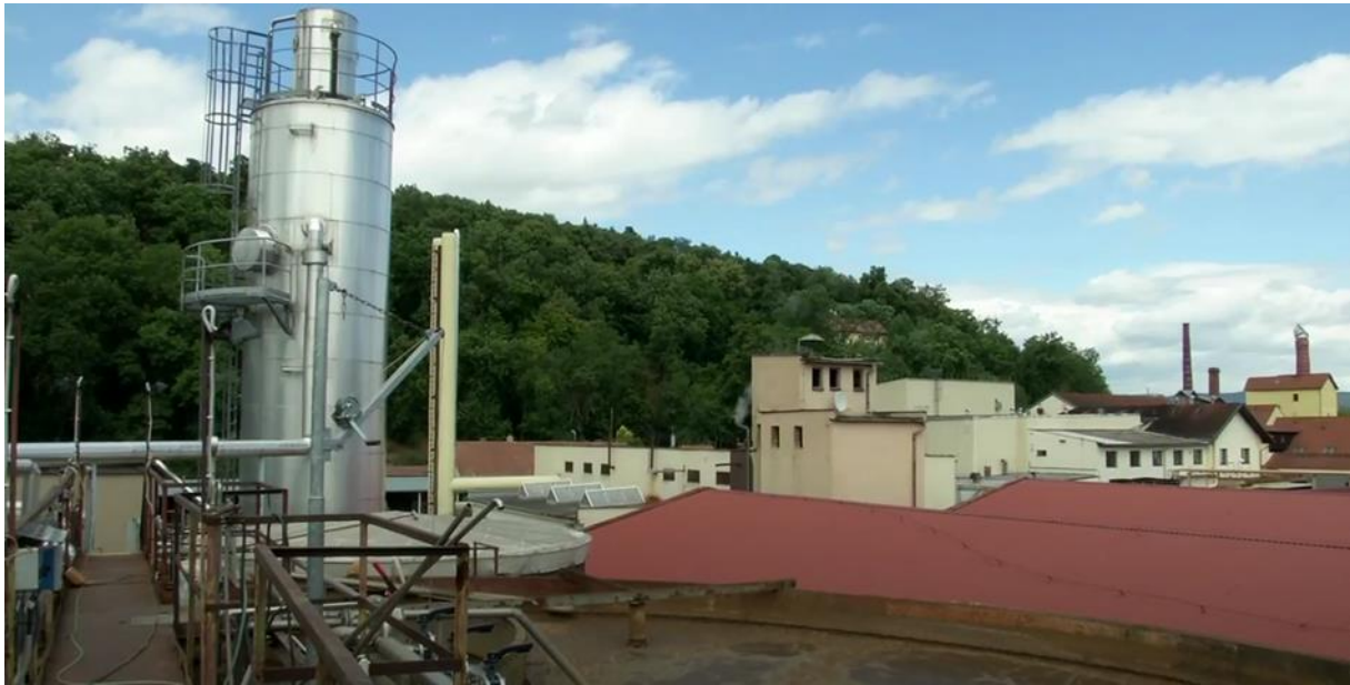
Slika 34. Pivovara Černa Hora, laguna za pročišćavanje otpadne vode i reaktor ( https://www.youtube.com/watch?v=_LS9IKcNwu4&t=1s )
