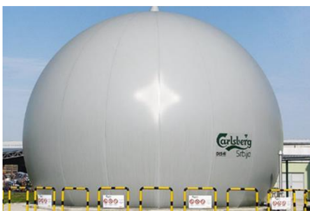
Slika 32. Skladište bioplina (Martinov M i sur. 2012)
