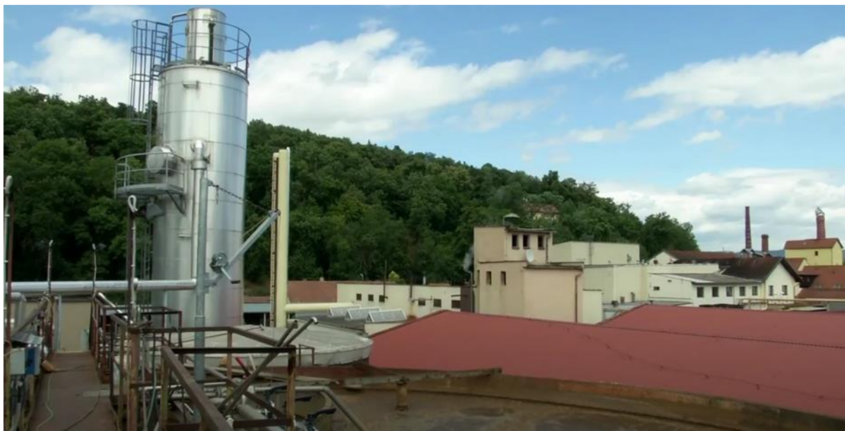
Slika 34. Pivovara Černa Hora, laguna za pročišćavanje otpadne vode i reaktor ( https://www.youtube.com/watch?v=_LS9IKcNwu4&t=1s )
